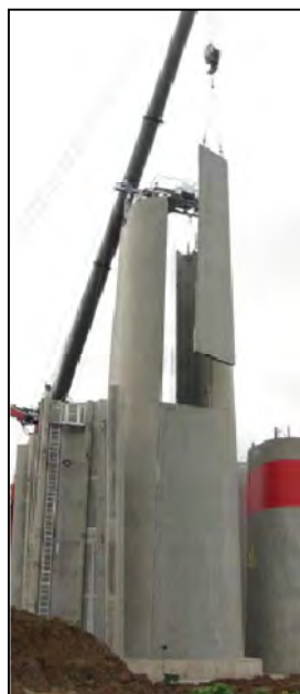
Figura 8: Ensamblaje de torre híbrida fabricada por la empresa A.T.S. (De Vries, 2009)
