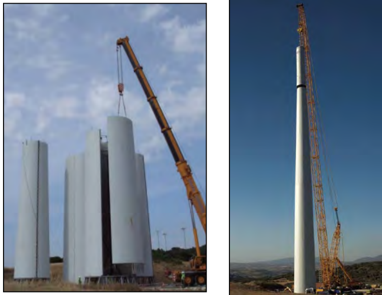
Figura 6: Montaje de torres prefabricadas de hormigón (Torres de Hormigón para Aerogeneradores Multimegavatio, 2009)
